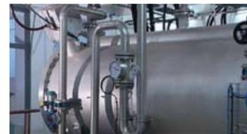
7 En bout de chaîne, l'eau parcourt un **lit de charbons actifs en grains**. Ce n'est plus une filtration, mais une **adsorption\*** qui permet de piéger les molécules de pesticides, celles-ci se fixant aux grains de charbon activé de molécule organique.
