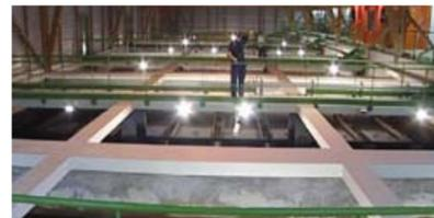
5 La **désinfection** est réalisée à partir de l'ozone produit sur le site. Elle permet d'éliminer les virus et bactéries.
