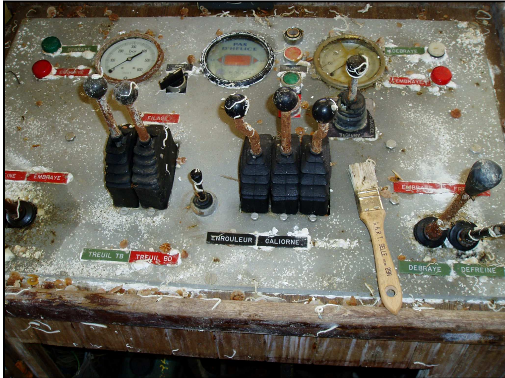
Vue de la console de commande des treuils à l'arrière tribord de la timonerie. La commande de frein du treuil bâbord est la manette située à l'extrémité droite de la photographie.
