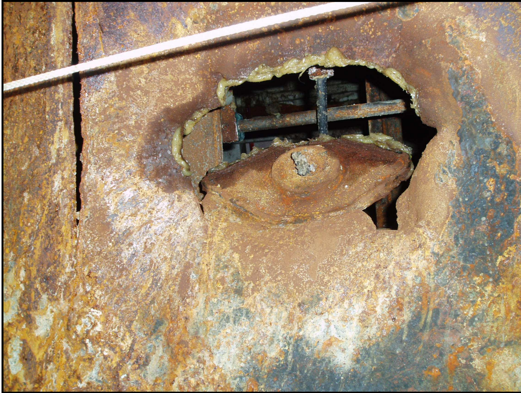
Vue de l'extérieur de la brèche située au niveau du sondeur bâbord. L'opercule est rentrée vers l'intérieur du compartiment moteur. On peut voir également la fissuration verticale au droit du couple 18.
