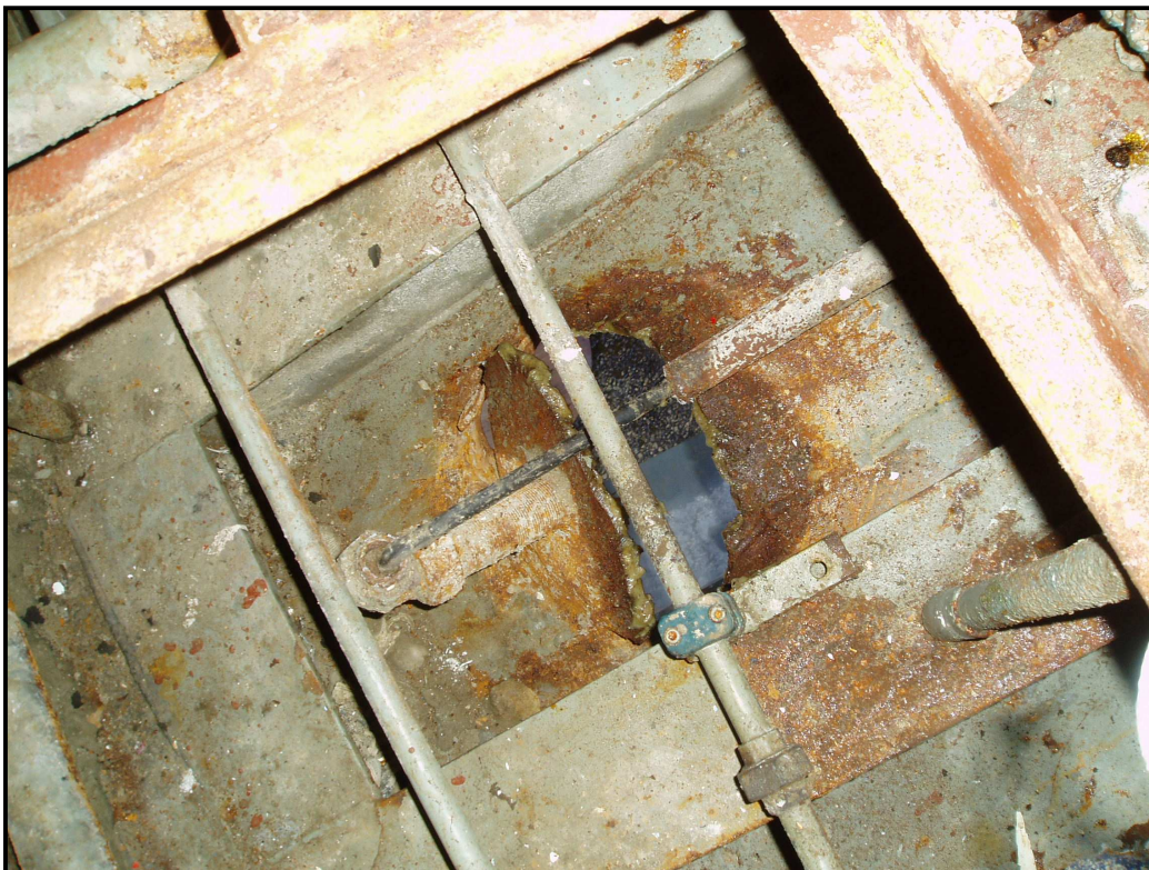
Vue de l'intérieur de la brèche située au niveau du sondeur bâbord. On peut voir sur la gauche de la photographie le tube guide-câble rompu au niveau du raccord. La partie du guide-câble montant vers le haut du compartiment moteur est visible sur la droite de la photographie.
