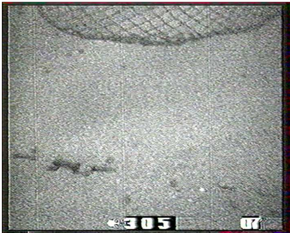
Vue du pignon bâbord. La chaîne émergeant du sédiment en bas de la photographie est celle du bras inférieur.
