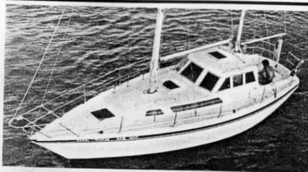
**Conception et coque :** Dessinée par Philippe Harlé, la carène du Gib'sea MS 100 est dérivée du Gib'sea 33 auquel a été ajouté un abri de navigation. Le lest assez long permet d'échouer aisément et le safran est suspendu. Dans le cockpit, tout à l'arrière et bien protégé, on trouve une barre franche sur la mèche de safran commandée par ailleurs par une barre à roue intérieure.
