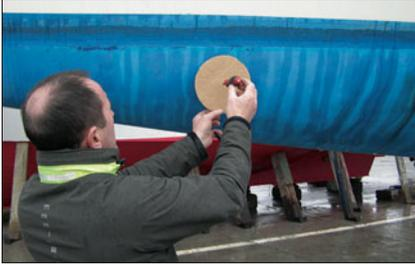
▲ La position du tunnel du propulseur d'étrave est très importante. Il doit à la fois trouver sa place dans les emménagements et être suffisamment avancé et profond pour être efficace. Ici on prend donc des repères à la fois sur l'étrave et sur la ligne de quille avant de tracer le passage du tube.
