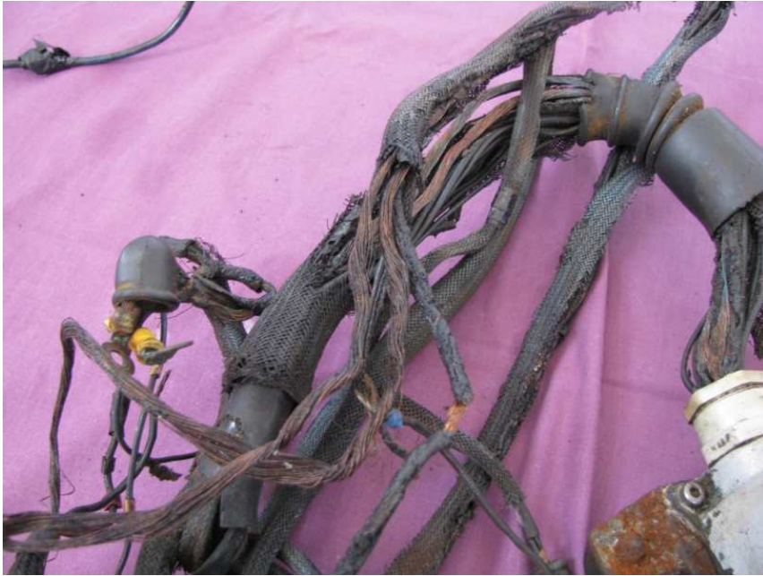
Faisceau moteur ancien (+/- 20ans) suite à un court circuit interne
