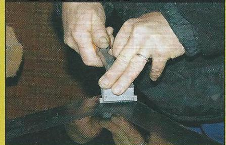
Non, il n'y avait pas d'antifouling sur le hublot ! En revanche, la raclette, plus maniable que le cutter, permet de retirer rapidement et efficacement les reliquats de joint. Nous n'insisterons jamais assez : la corvée de nettoyage-ponçage-dégraissage des surfaces est fondamentale pour créer une bonne accroche. Elle a été faite avec d'autant plus de soin que le propriétaire avait tenté d'améliorer l'étanchéité du hublot avec de la silicone, ennemi n°1 de l'accroche mécanique et chimique.
