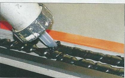
La nature a horreur du vide, tel est le principe d'étanchéité du nouveau joint. On remplit donc la gorge d'un joint polyuréthane (Sikaflex 295-UV) entre le joint mousse et le rebord. Contrairement au montage d'origine, l'air et donc l'eau, par condensation, ne pourront pas séjourner dans la gorge : tout est entièrement comblé par le joint.
