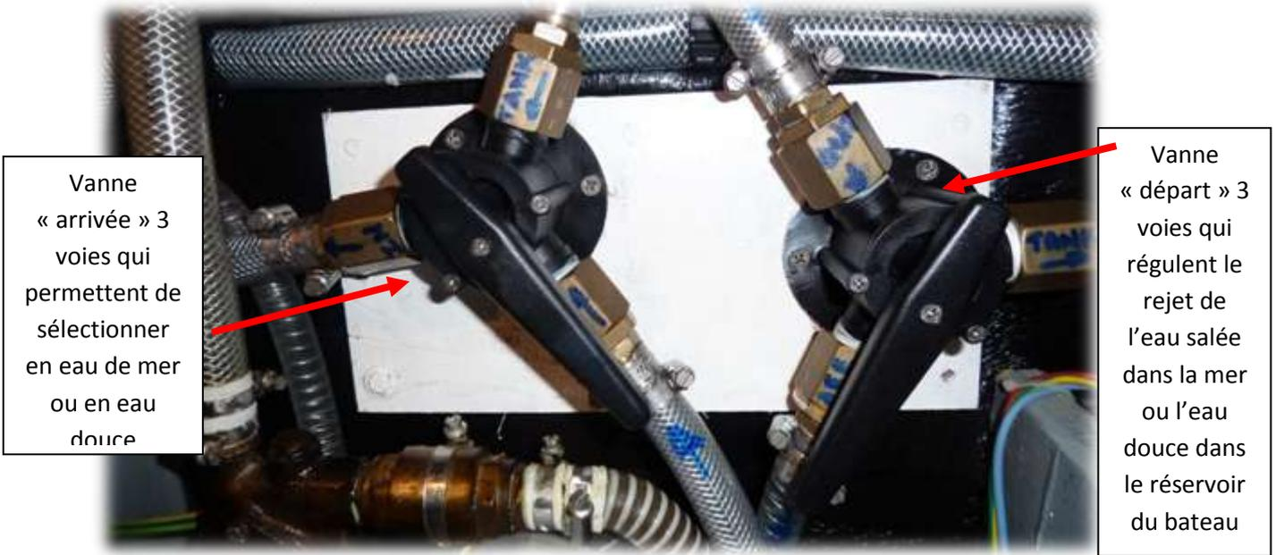
Installation de deux vannes 3 voies qui permettent de basculer en alimentation et rejet eau de mer ou eau douce
