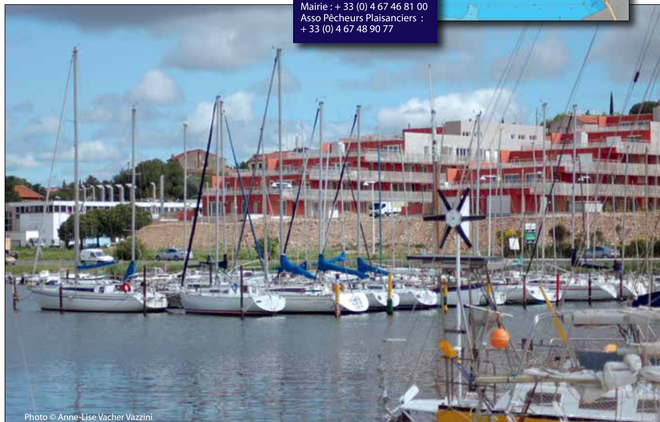
Balaruc-les-Usines change d'aspect avec le nouveau programme immobilier en terrasses sur le bassin de Thau
