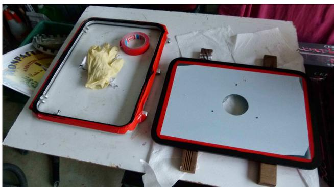
Après une heure, on pose le cordon de SIKA sur le cadre, dans l'angle de l'équerre qui reçoit le plexi. On pose délicatement le plexi en place et on recentre avec les allumettes. Et c'est là qu'on est content de refaire le carrelage de sa terrasse, car les paquets de carreaux de 25kgs sont parfaits pour peser sur le plexi, afin d'avoir la pression suffisante pour parfaire le collage. On peut à présent aller prendre un apéro bien mérité.
