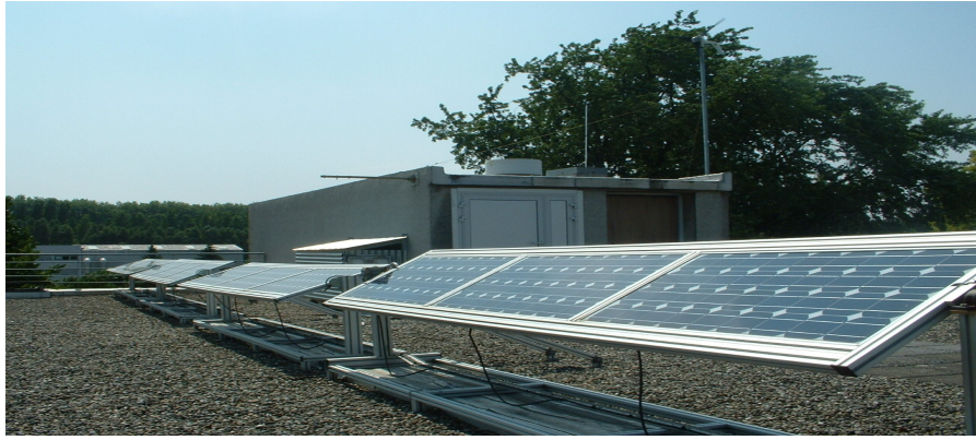
Figure 2.12 : Site photovoltaïque du LAAS-CNRS
