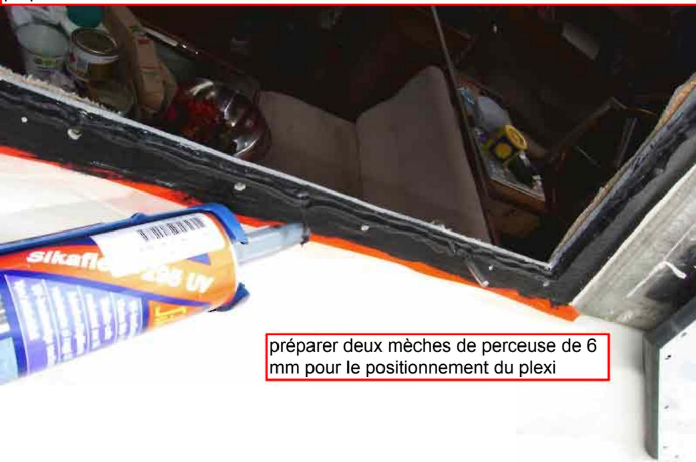
préparer deux mèches de perceuse de 6 mm pour le positionnement du plexi
