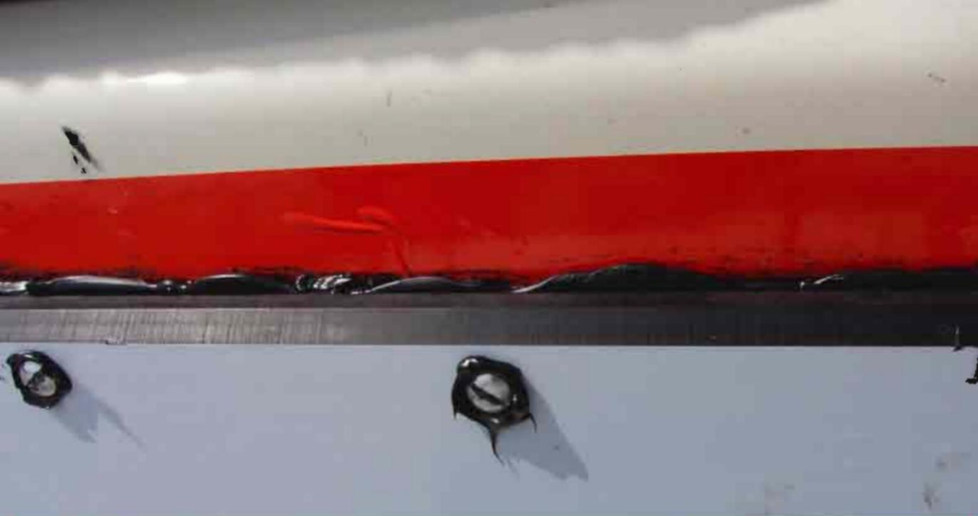
une fois toutes les vis serrées: 2 options, on a été rapide et le sica est encore mou, le lisser avec un doigt enduit de produit vaisselle et tout de suite enlever le scotch rouge. Option deux on a pris son temps, on coupe à ras le plexi le joint de sica durci et on refait un joint de finition au sica que l'in lisse au doigt mouillé de produit vaisselle et l'on enlève scotch tout de suite.
