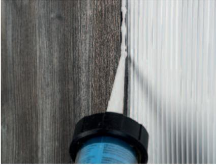
Avant l'encollage de **RESOPAL SpaStyling® BOARD** sur le support, il faut avoir réalisé toutes les étapes de façonnage (découpe, évidement, perçages, fraisages de rainures, etc.). Ce n'est qu'ensuite que peut commencer le collage.
