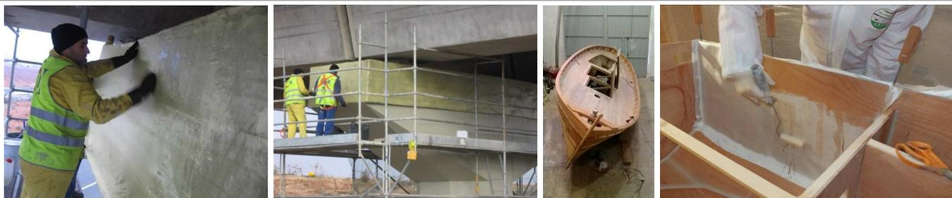
**RESOLTECH 1020 / 102xS** est un système époxy de stratification fluide sans stade B, permettant de réaliser des pièces en bois/époxy. Ce système est préconisé pour la stratification et le revêtement de supports poreux tels que le bois et le béton. Il convient également pour la protection de structures métalliques et le renforcement de structures composites.
