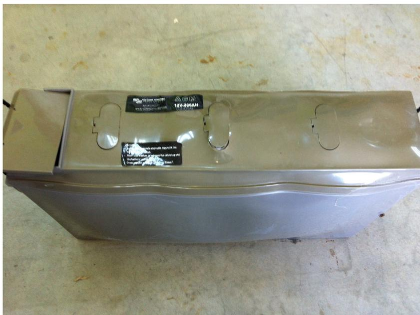
Batteries collées les unes contre les autres et sonde de température du chargeur non installée !
